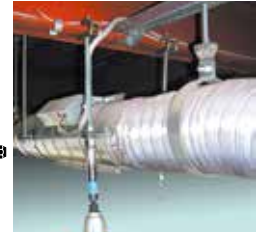
ボルト出代が長い場合のナット締め。
