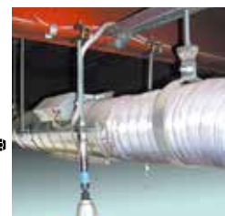
ボルト出代が長い場合のナット締め。
