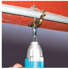
軸がねじれない軸部圧入式
